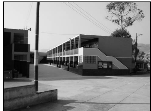
Les bâtiments du collège à ce jour
