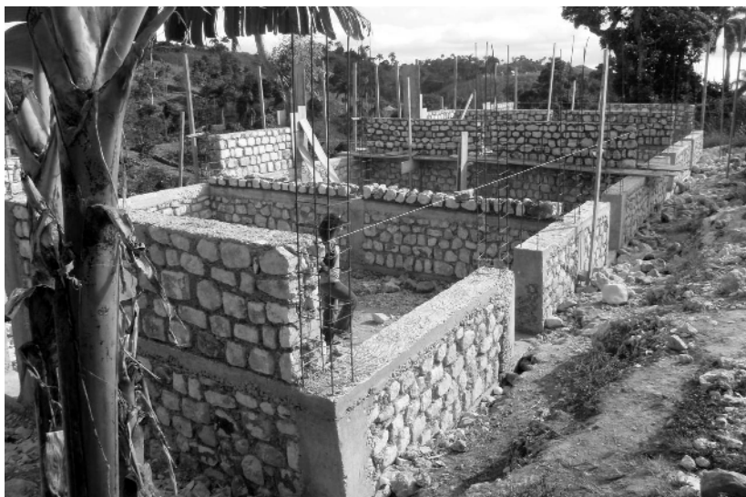
Chantier de l'école de la Providence - Zone de (Delatte - novembre 2011)
