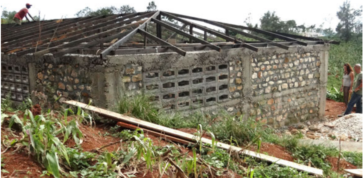
Nouvelle construction : école Cincinnatus
