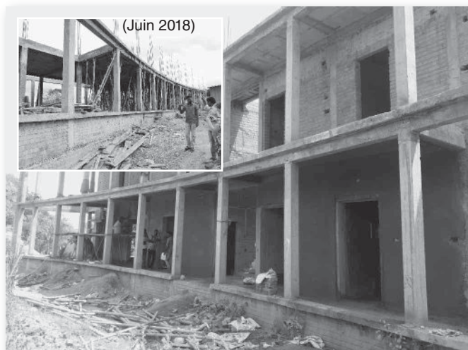
(Mars 2019) Les travaux avancent dans le futur foyer Kurinji.
